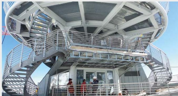
Con il progetto Punta Helbronner, Tecnolafer ha nuovamente varcato i confini e ha progettato, realizzato e installato i parapetti per le scale e le terrazze panoramiche della stazione Skyway Monte Bianco, a 3.466 metri di altitudine.
