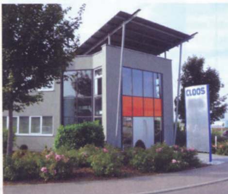
Das neue „Cloos Welding Center“ in Flein.
